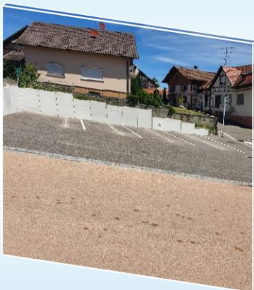
Modification du marquage parking mairie
